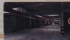
podziemne hale garażowe
