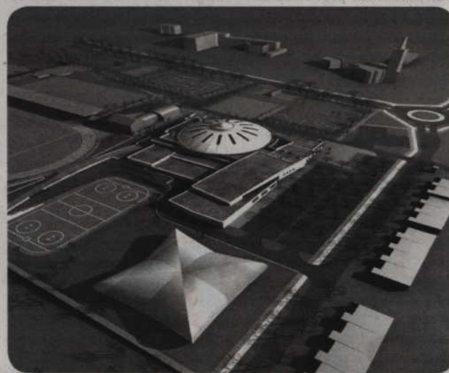
Budowa kompleksu sportowego powinna zakończyć się na przełomie października i listopada 2011 r.
