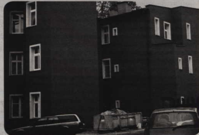
W tym roku planuje się ok. 13-14 remontów kamienic wspólnot oraz 3 lub 4 kamienic należących do miasta.
