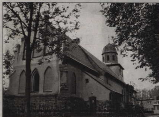
Remont kościoła w Obrzynowie.
