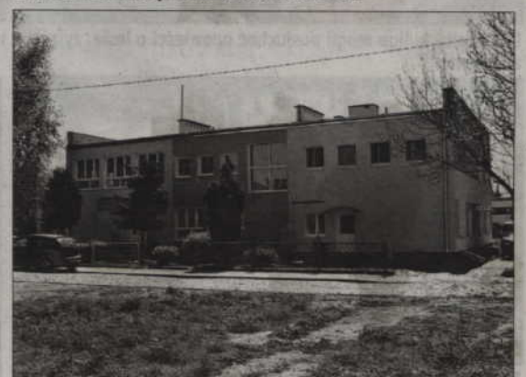
Wyremontowane przedszkole Bratek.
