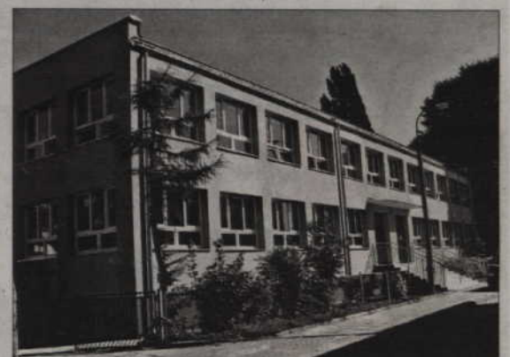
Zmodernizowane przedszkole Miś Uszatek.
