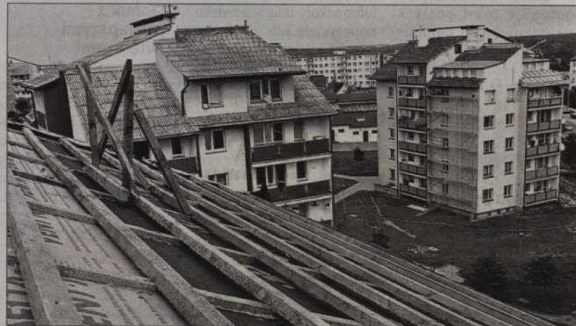
Usuwanie azbestu z dachów to długofalowy program realizowany w całym powiecie kwidzyńskim. Na zdjęciu demontaż azbestu z bloków przy ul. Polnej. Fot. Mirosław Wiśniewski
