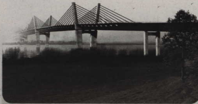
Dyrekcja Dróg Krajowych i Autostrad w Gdańsku, która jest investorem przedsięwzięcia, ogłosiła 24 marca przetarg na zarządzanie i nadzór inwestorski nad budową mostu wraz z drogami dojazdowymi. Inwestycja ma potrwać 27 miesięcy. Zakończenie budowy ma nastąpić pod koniec 2012.
