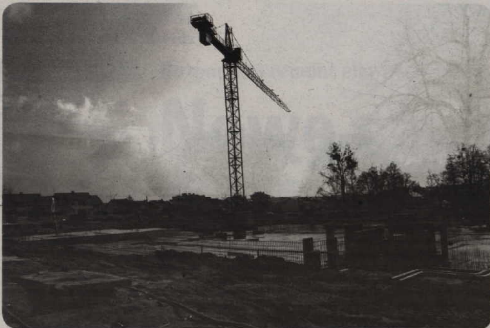
Wylano płytę pod budowę hali. Powierzchnia użytkowa obiektu będzie miała ponad 3,9 tys. m 2 . Całkowita powierzchnia przekroczy 9,1 tys. m 2 . Kubatura obiektu wyniesie ok. 61 tys. m 3 .
