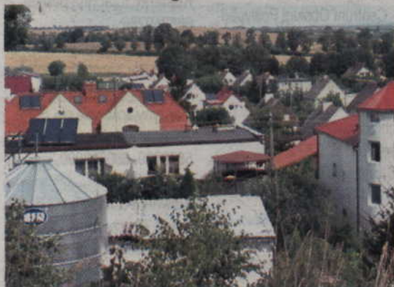
Przybywa dachów, na których montowane są kolektory słoneczne. Najczęściej służą do wytwarzania energii cieplnej.
