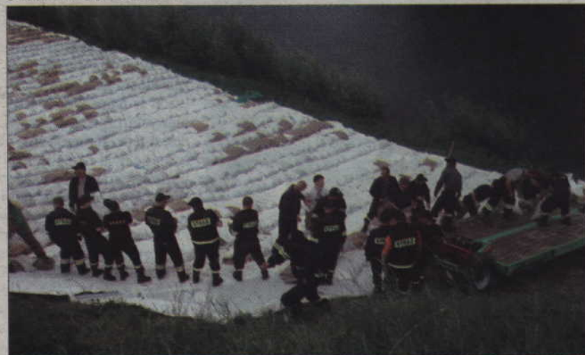
Przy zabezpieczeniu wału pracowali strażacy i mieszkańcy.
