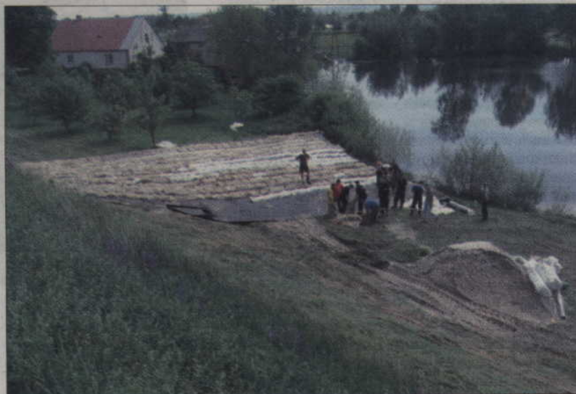
Nad Wisłą w Grabowie ułożono pięć tysięcy worków z piaskiem, by zapobiec przesiakaniu wału.
