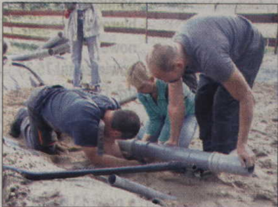
- Szczelność przydomowej oczyszczalni jest bardzo ważna, dlatego całą instalację trzeba dokładnie zmontować.
