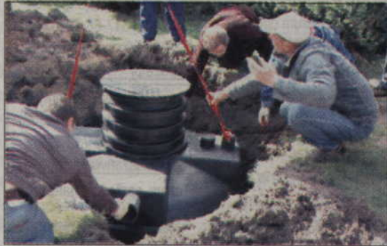
Jeden z etapów budowy przydomowej oczyszczalni, czyli montaż zbiornika ścieków.
