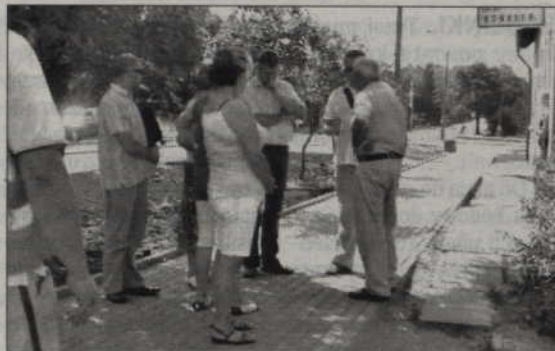
Trwa przebudowa skrzyżowania dróg wojewódzkich nr 521 - 522. Fot. Prabuty.pl
