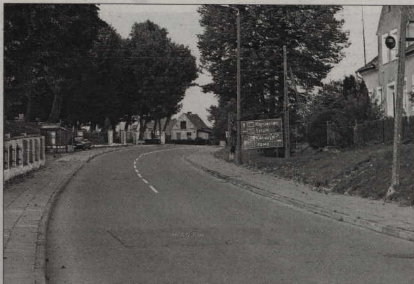
Na terenie gminy Prabuty jest wiele starych zniszczonych budynków, które wymagają natychmiastowego remontu.
