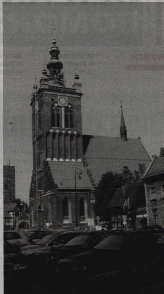
Kościół św. Katarzyny w trakcie prac konserwatorskich, lipiec 2010 r. Fot. Wacław Rasnowski
