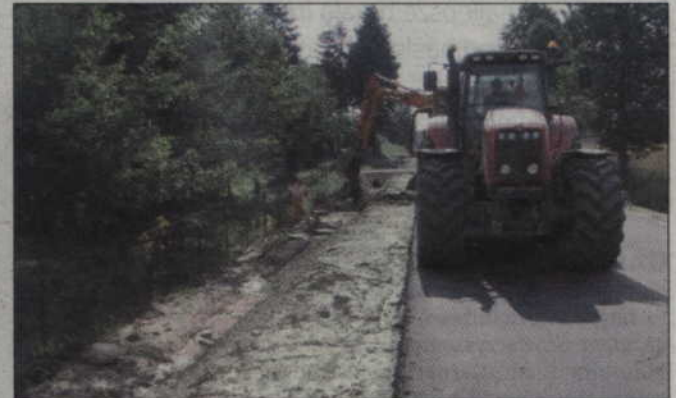
W Straszewie trwają m.in. prace nad odwodnieniem powstałej drogi.
