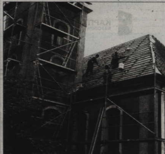
Remont kościoła ma zakończyć się w październiku.
