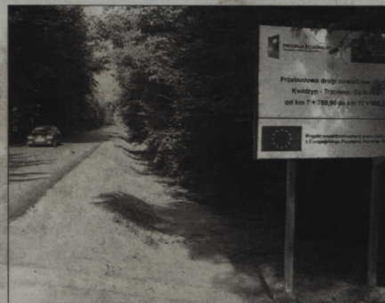
Aktualnie finalizowany jest II etap modernizacji drogi Kwidzyn - Pierzchowice.
