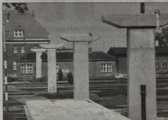
Kładka nad torami okazała się zbawieniem dla mieszkańców, którzy, by przejść z jednej części miasta do drugiej, musieli nadkładać drogi. Kwidzyn na dwa części - starą i nową - dzielią tory kolejowe.
