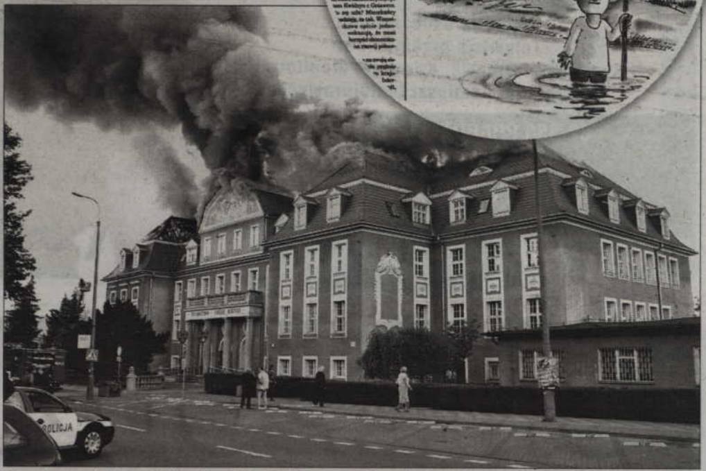
Dramatyczne chwile przeżyli kwidzynianie trzy lata temu, gdy w płomieniach stanął budynek Urzędu Miejskiego.
