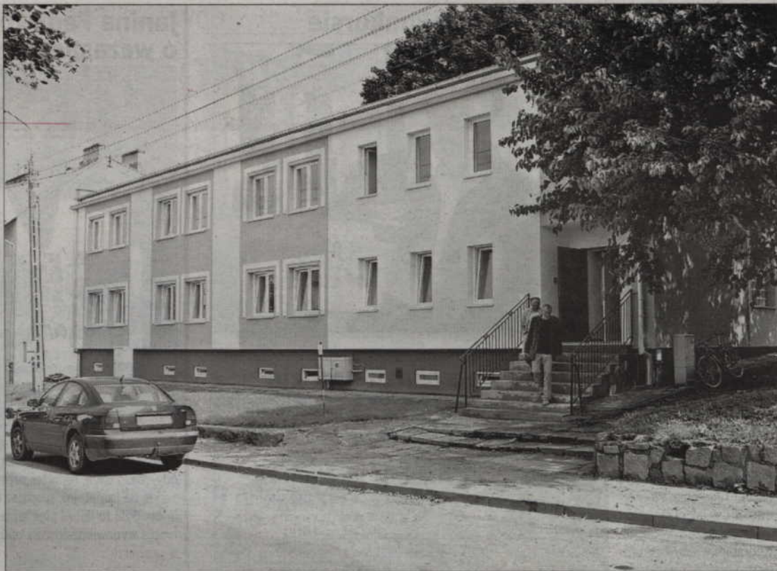
W wyremontowanym budynku przy ul. Łąkowej powstało dziesięć mieszkań.
