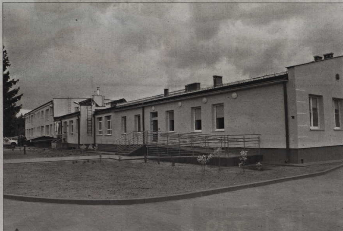
Nowe pomieszczenia ośrodka w Barcicach.
