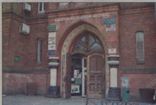
Wejście do biblioteki przy ul. 11 Listopada.
