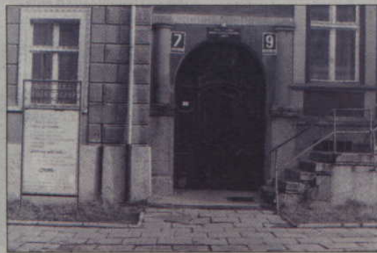
Opr. (ad) Wejście do biblioteki przy ul. Grudziądzkiej 9.
