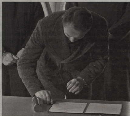
Budowę mostu rozpoczęto wmurowaniem aktu erekcyjnego pod jednym z elementów przyszłej estakady prowadzącej do mostu.
