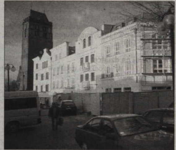
Prace przy budowie pierwszej kamienicy kwidzyńskiej starówki powinny zakończyć się do końca listopada.
