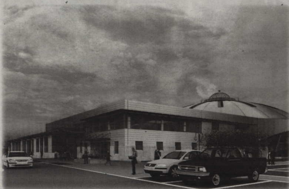
Dokończenie budowy kompleksu sportowego przy ul. Wiejskiej to największa przyszłoroczna inwestycja miasta.
