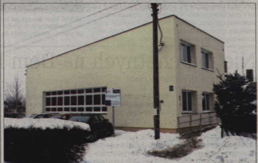
Modernizacja budynku była możliwa dzięki unijnej dotacji.
