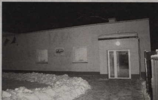
Sala tradycji powstała w budynku, w którym dawniej znajdowała się hydrofornia. Przed remontem obiekt był kompletnie zdewastowany.
