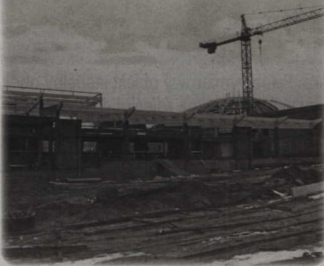
Hala sportowa i kryta pływalnia mają zostać oddane do użytku do końca tego roku. Fot. archiwum
