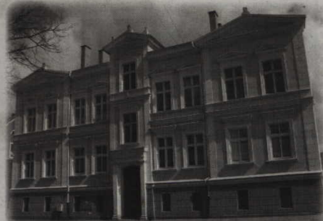
Zakres prac, dotyczących remontów wspólnot mieszkaniowych, dofinansowywanych przez miasto, w formie spłaty odsetek, obejmuje remont elewacji, docieplanie budynków, remont dachu.
