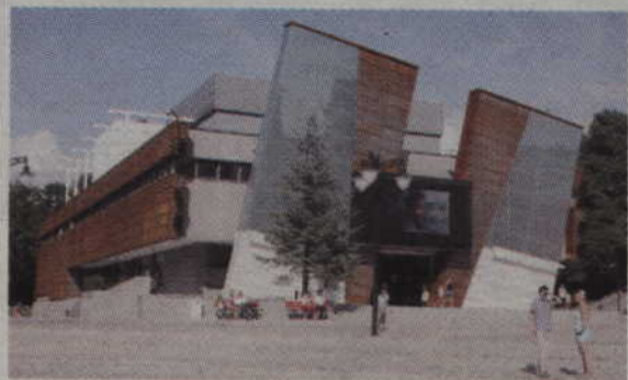
Telebim znajduje się na frontowej ścianie miejskiego teatru na placu Jana Pawła II. Budynek odnowiono i nadano mu kształt barki - na cześć polskiego papieża. Fot. Mirosław Wiśniewski
