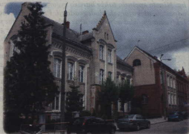
Samorząd miasta zamierza rozpocząć remont budynku, w którym znajduje się siedziba Gimnazjum nr 1. Fot. archiwum
