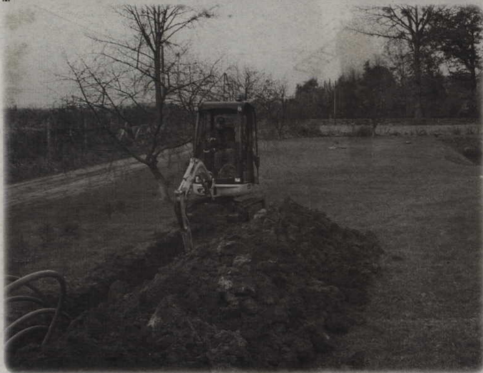
Dobiega końca budowa kanalizacji sanitarnej Podzamcze-Gurcz. Inwestycja została dofinansowana ze środków unijnych.
