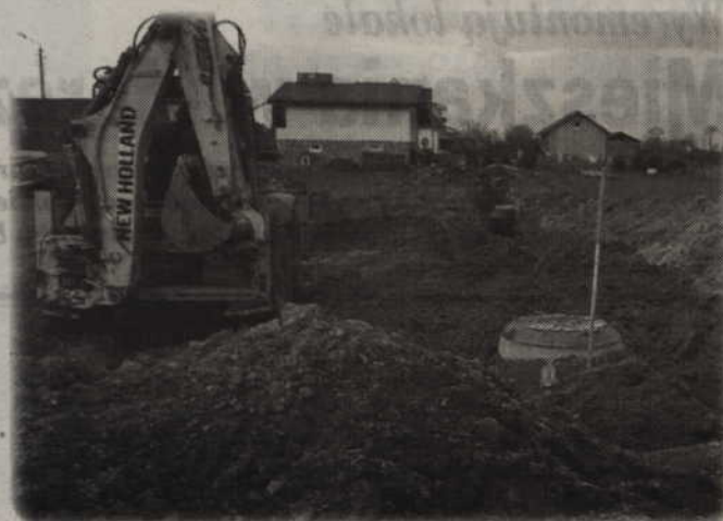
Budowa kanalizacji na ul. Słonecznej w Rakowcu.
