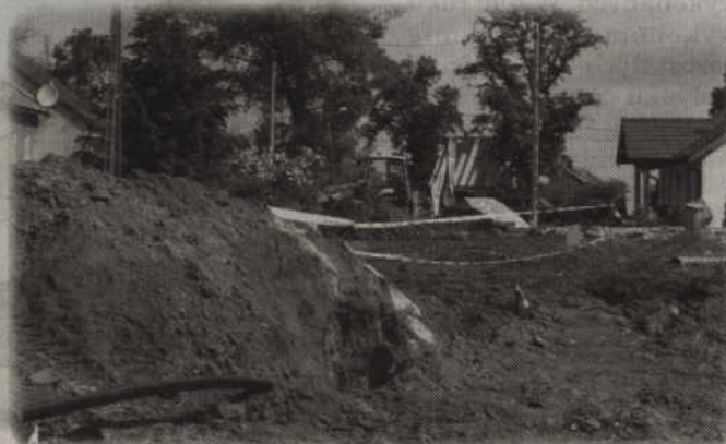
Rozpoczęła się budowa wodociągu w Korzeniewie. Sieć powstanie w rejonie ul. Kwidzyńskiej. Będzie miała ok. 1 km długości.
