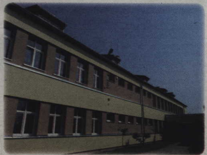
Wymienione zostało już pokrycie dachowe na całym budynku oraz okna.
