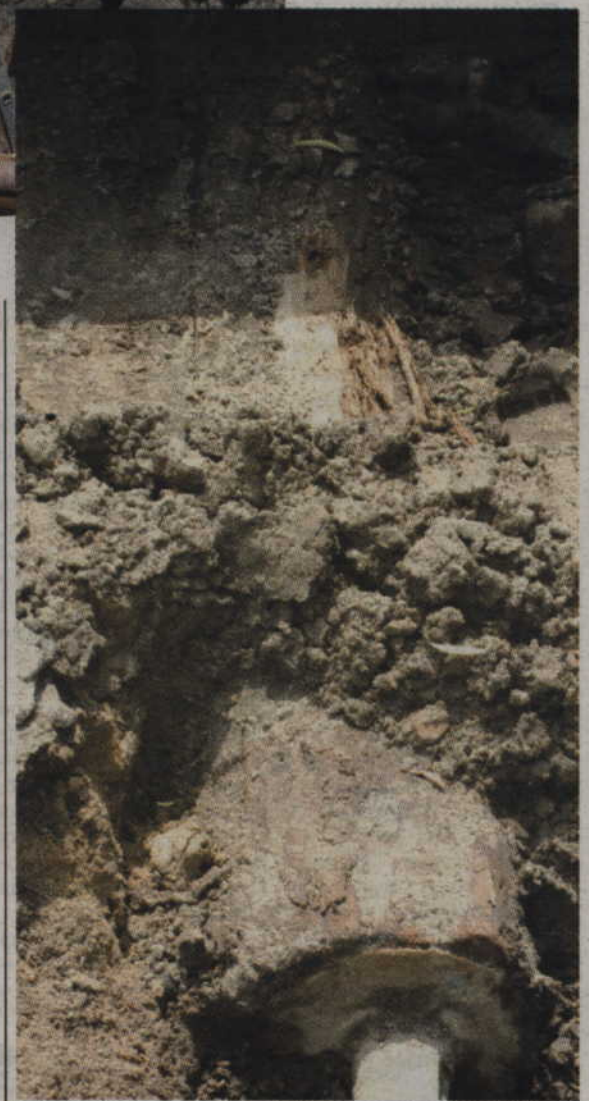
Odkopany fragment wodociągu być może pochodzi z XVII lub XVIII wieku.
