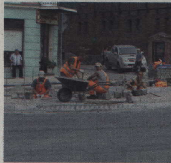
Prace przy budowie ronda powinny zakończyć się do końca sierpnia.
