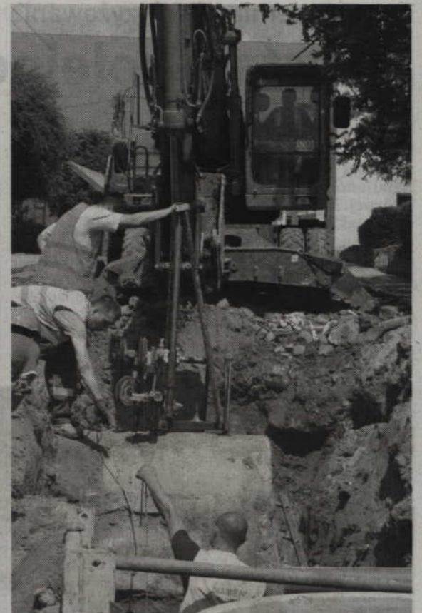
Przebudowa kanalizacji na ulicy Podjazdowej ma zakończyć się z końcem wakacji.
