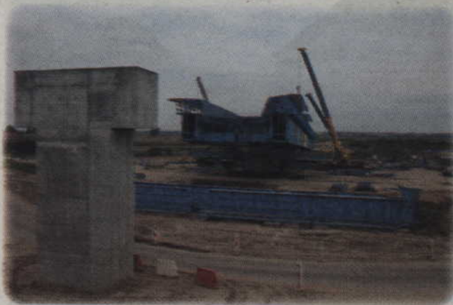
Coraz bardziej widoczne są postępy w budowie mostu przez Wisłę.
