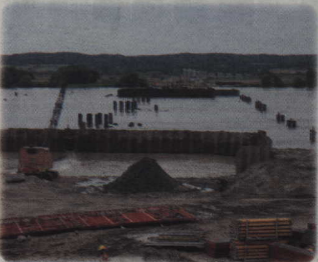
Postępy przy budowie mostu można obserwować w Lipiankach, w gminie Kwidzyn.
