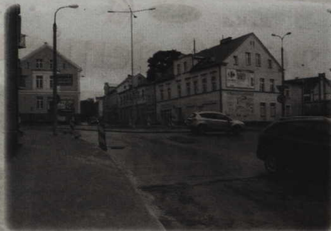
Trwają ostateczne prace, które poprawią organizację ruchu w tej części miasta.
