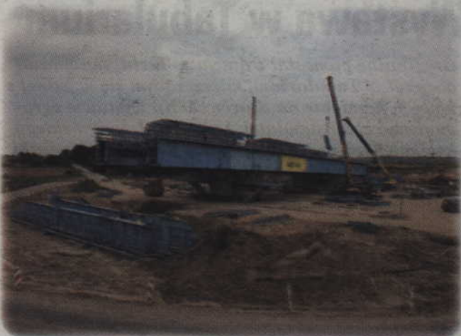
Most będzie miał ponad 800 m długości. Konstrukcja typu extradosed (z ang. Extradosed prestressed bridge) będzie największą tego typu w Europie i jedną z największych na świecie.
