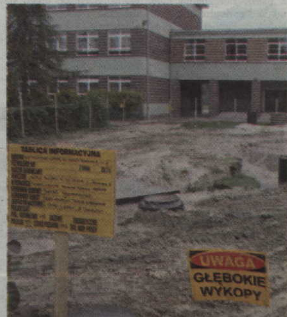
Przed Szkołą Podstawową nr 4 powstaje rondo. Prace mają potrwać do końca września.
