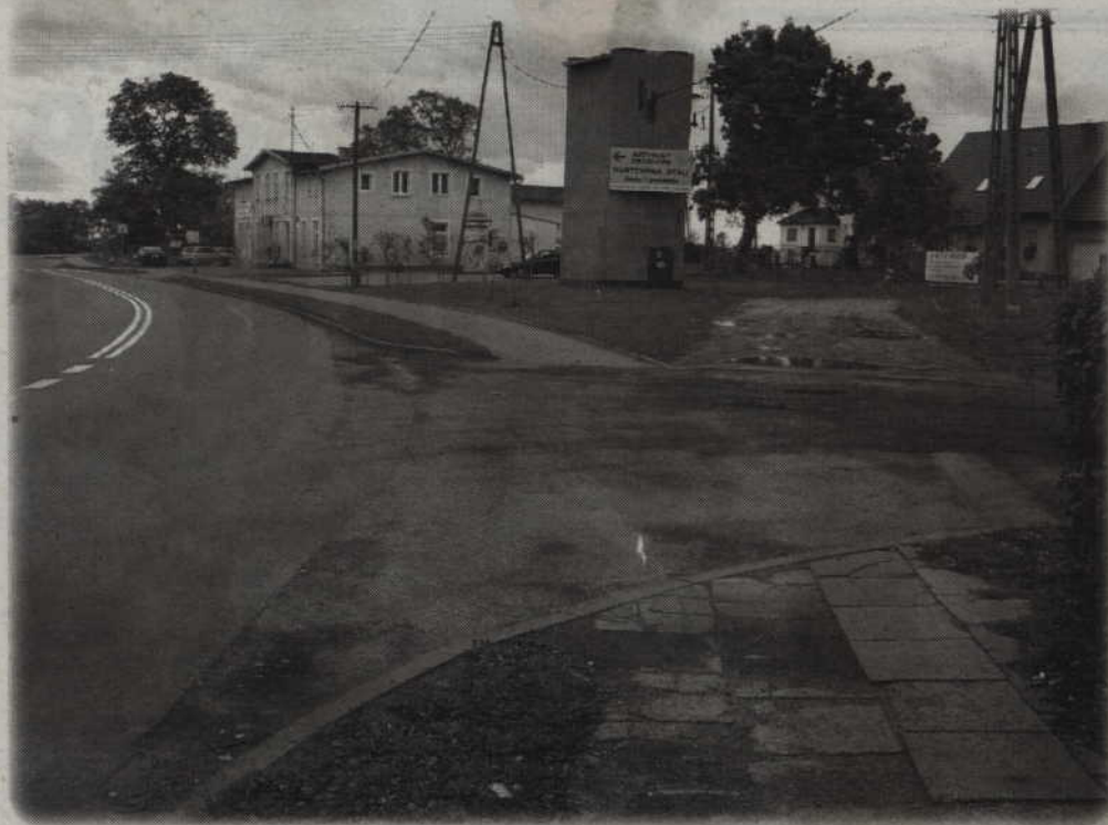
W Tychnowach powstanie ścieżka pieszo-rowerowa. Będzie miała ok. 1 km długości. Powstaną także trzy zatoki autobusowe.
