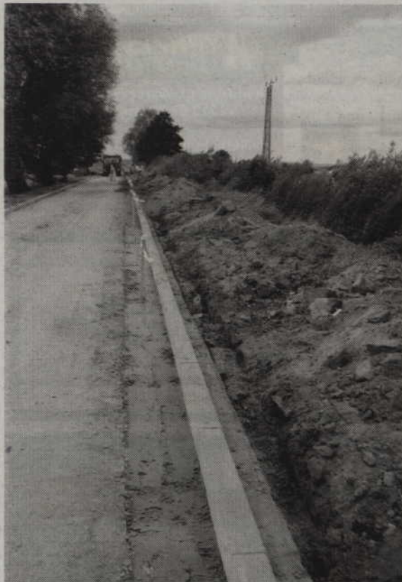
Trwa modernizacja drogi Nowy Dwór Kwidzyński-Rozpędziny.
