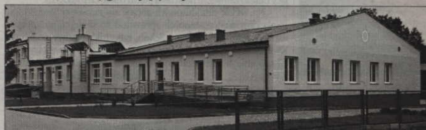
W budynku SOSW w Barcicach zniszczeniu uległ zbiornik do odprowadzania ścieków. Fot. Mirosław Wśniewski
