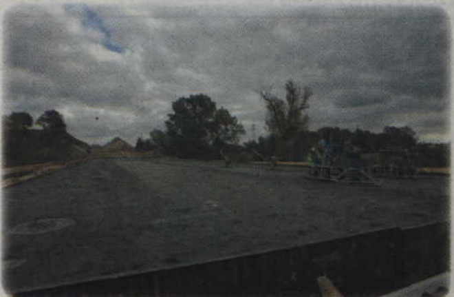
Koszt całej inwestycji, włącznie z wykupem gruntów, nadzorem inwestorskim oraz budową dróg dojazdowych, o łącznej długości prawie 12 km, wyniesie ok. 380 mln zł. Zdjęcia: Aleksander Lubiński
