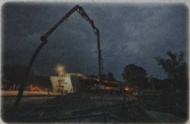
Postępy przy budowie mostu można obserwować w Lipiankach, w gminie Kwidzyn
