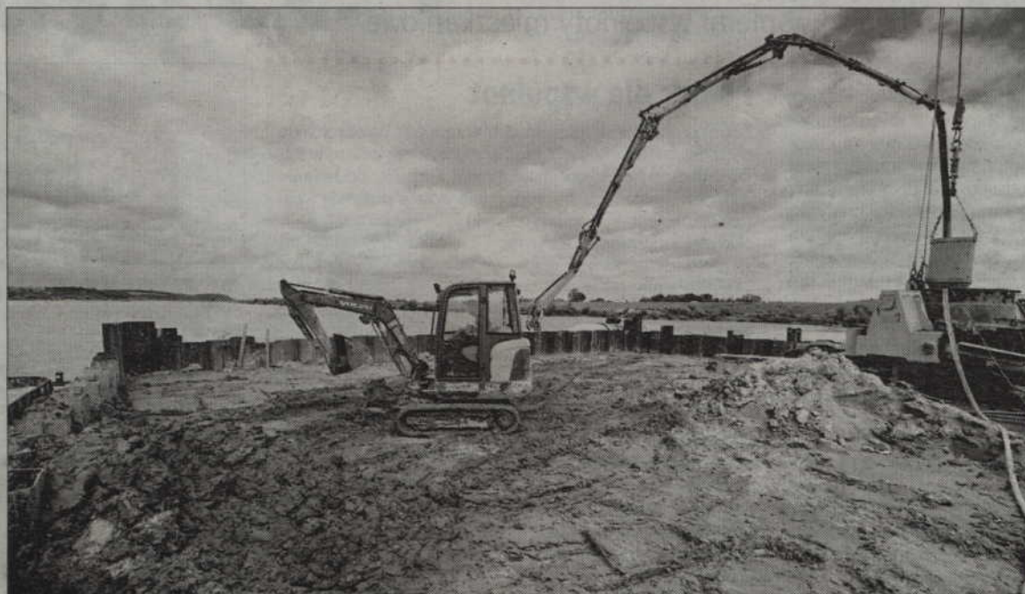
Prace przy budowie mostu przez Wisłę trwają pełną parą.
