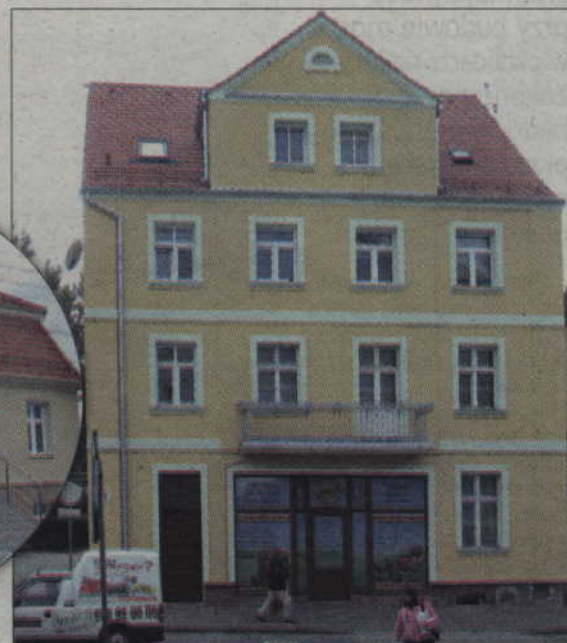
Nowy wygląd zyskała kamienica przy ul. Grudziądzkiej 14. Remont udało się doprowadzić do końca mimo problemów formalno-prawnych. Samorząd liczy, że uda mu się przejąć ten budynek. Zdjęcia: Mirosław Wiśniewski
