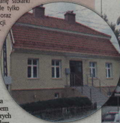
Budynek przy ul. Żelaznej 15 był w bardzo złym stanie technicznym. Trzeba było wykonać tu kapitalny remont.
