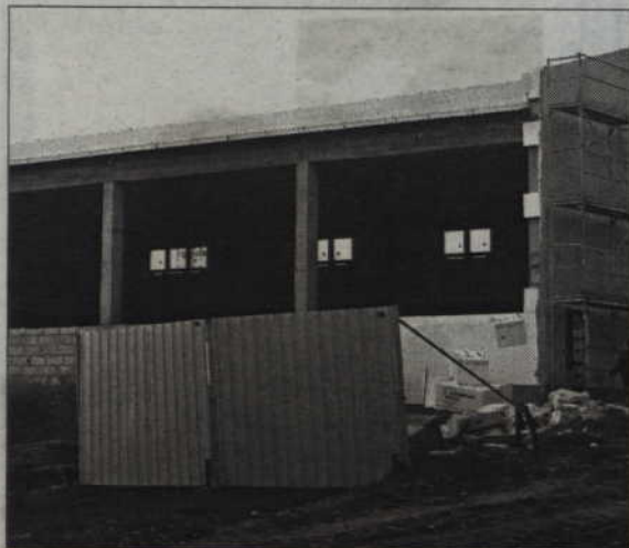
Budowa sali gimnastycznej w Trumiejkach miała zakończyć się w grudniu, ale wszystko wskazuje na to, że wykonawca nie dotrzyma terminu. Fot. Michał Maruniak
