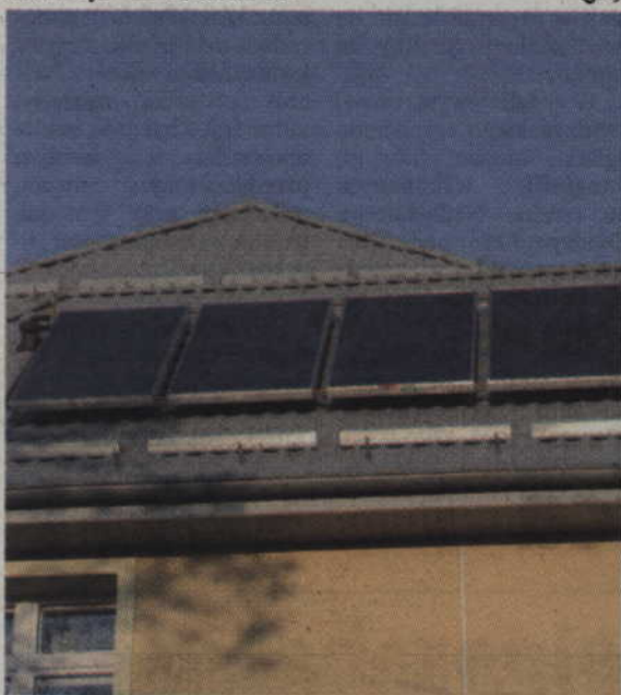
20 solarów ogrzewa trzy budynki o łącznej powierzchni 4 tys. m kw.
