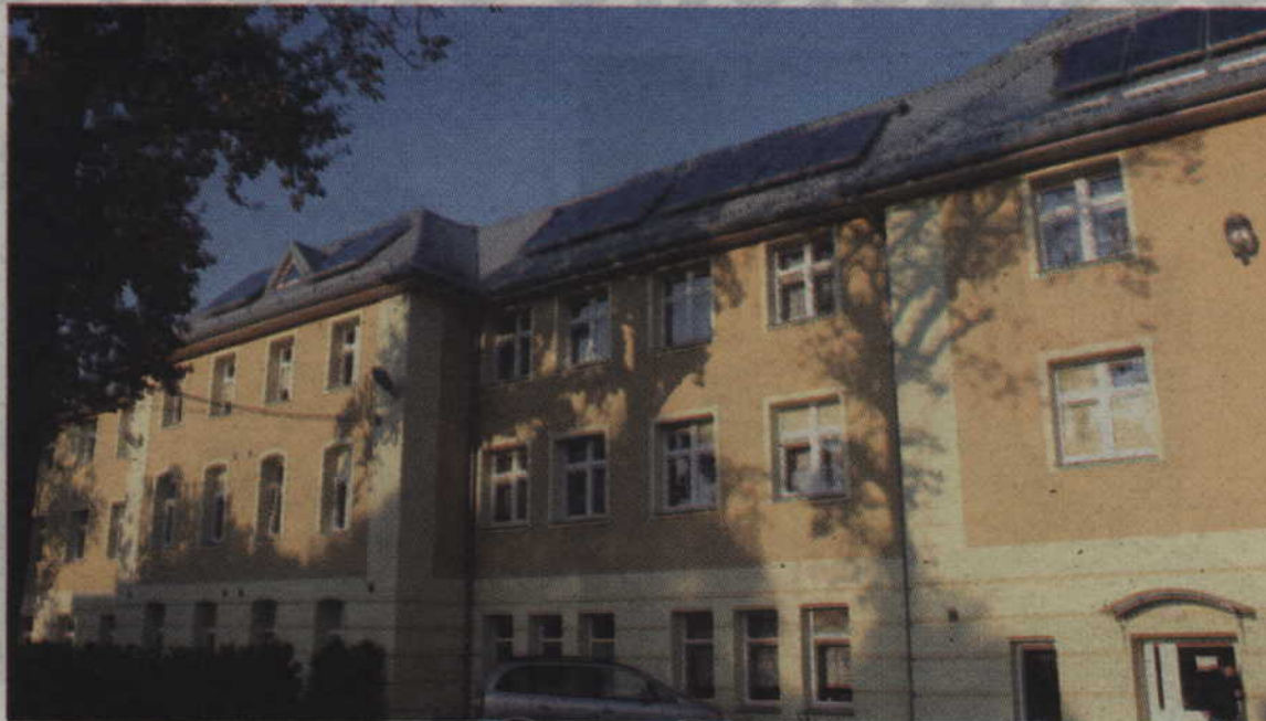
Na dachu Domu Pomocy Społecznej w Kwidzynie zainstalowano kolektory słoneczne.
