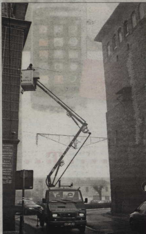
Montaż świątecznego oświetlenia w Prabutach.
