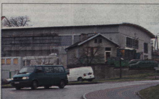
Budowa hali sportowej przy Zespole Szkół Ponadgimnazjalnych nr 2 w Kwidzynie. Koszt to ponad 8 mln zł. Przewidywany termin zakończenia prac: czerwiec.
