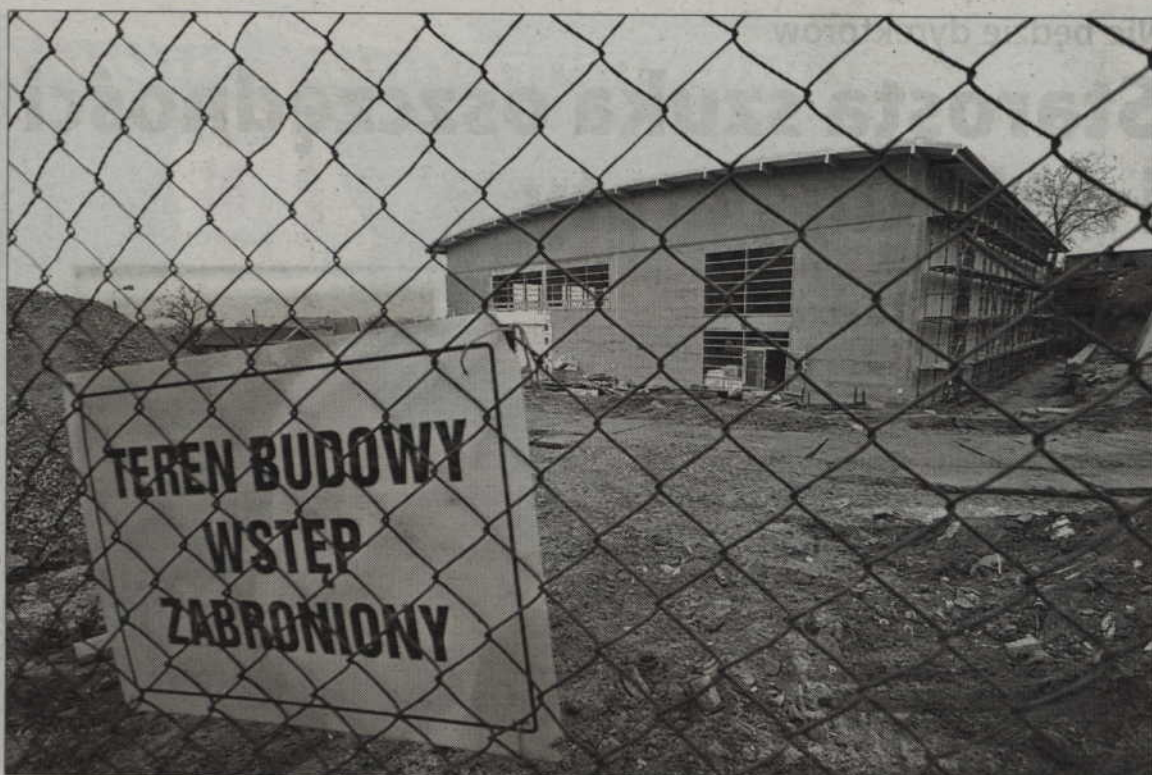
Budowa hali dla ZSP nr 2 w Kwidzynie ma zakończyć się w czerwcu.
