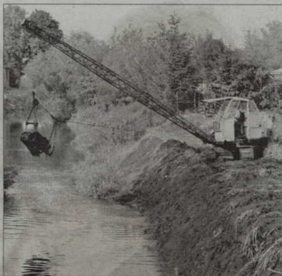
Hakowanie dna rzeki Liwy zostało wykonane w ubiegłym roku na odcinku od Białej Góry do Rozpędzin. Całkowity koszt tych prac to 207 tys. zł.
