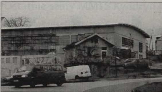
Okazuje się, że aby ustabilizować skarpy przy budowanej właśnie hali dla Zespołu Szkół Podstawowych nr 2 w Kwidzynie niezbędne jest wbicie w nią stalowych grodzii.
