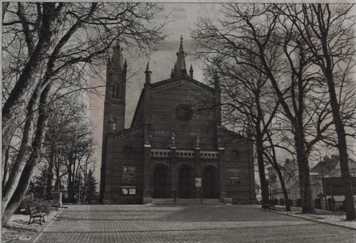
W kościele pw. św. Trójcy w Kwidzynie wyremontowany zostanie zabytkowy ołtarz. Prace ruszą 23 lutego.
