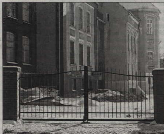
Remont budynku po Gimnazjum nr 1 pochłonie blisko 4 mln zł.
