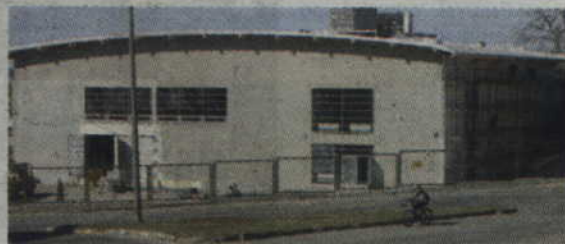
W nowej hali, z której będą korzystać uczniowie Zespołu Szkół Ponadgimnazjalnych nr 2 w Kwidzynie, trwają prace wykończeniowe. Inwestycja zostanie oddana do użytku w czerwcu tego roku. Fot. Mirosław Wisniewski
