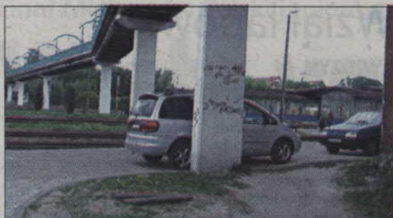
Dziura znajduje się w pobliżu budynku kwidzińskiego dworca.
