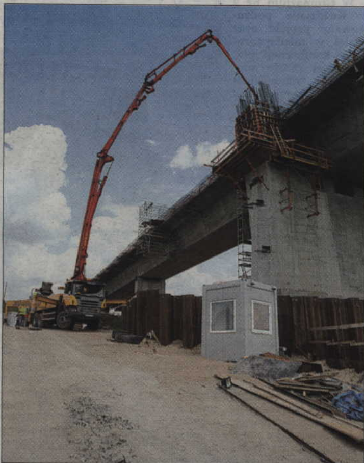
Most przez Wisłę w okolicach Kwidzyna będzie jedynym takim mostem w Europie.
