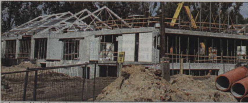
Budowa Kwidzyńskiego Parku Przemysłowo-Technologicznego ma kosztować ok. 41,5 mln zł. Blisko 29 mln zł to pieniądze pochodzące z funduszy unijnych.
