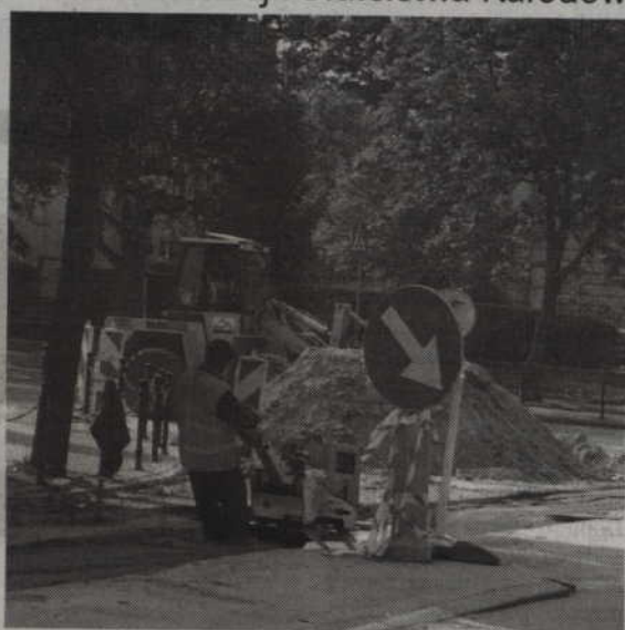
Dzięki tej inwestycji rozdzielony zostanie system kanalizacji ogólnospławnej, na kanalizację sanitarną i deszczową.
