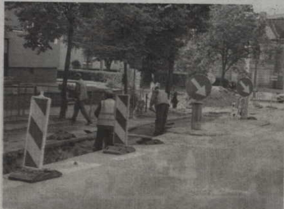
Prace remontowe na ulicy Warszawskiej potrwać do 26 listopada.
