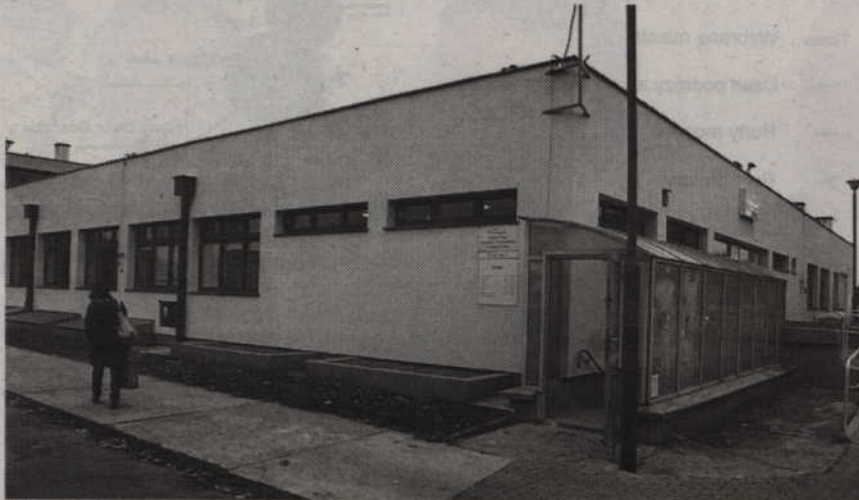
Filia nr 1 znajdująca się przy ul. Słowackiego mieści się w piwnicy budynku pływalni. Fot. Mirosław Wiśniewski
