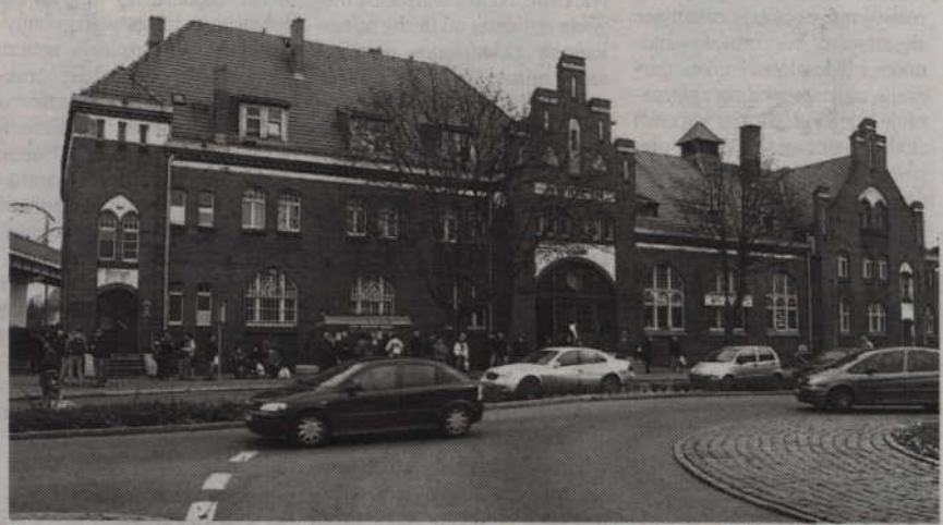
Wyremontowany budynek kwidzińskiego dworca kolejowego pomieści ma zbiory biblioteki miejsko-powiatowej oraz wszystkich jej filii. Fot. Mirosław Wiśniewski
