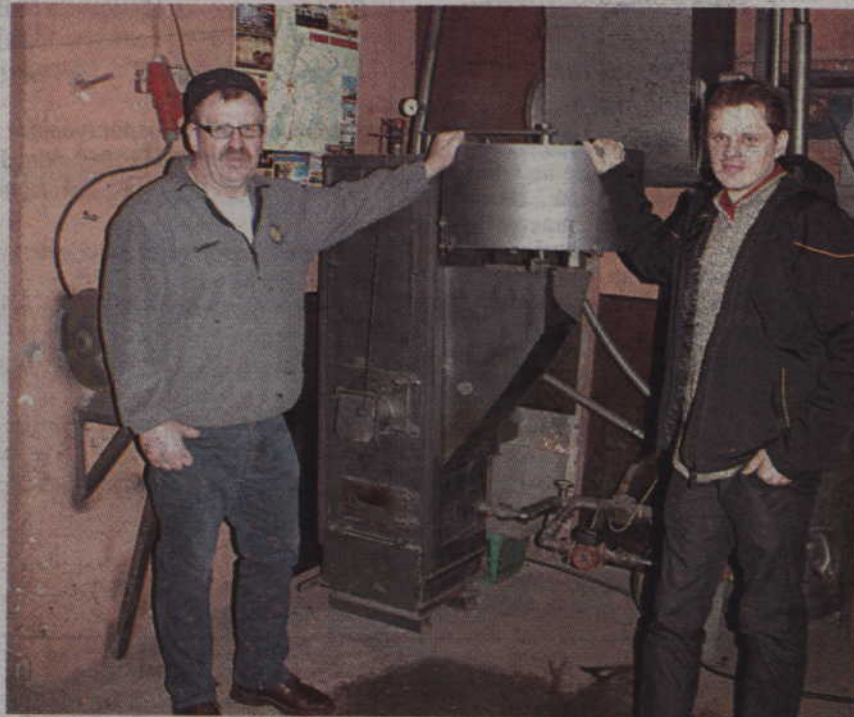
Marian Strzelczyk, wynalazca i właściciel firmy „WERY” (z lewej) oraz Krzysztof Majewski, partner firmy „PanEd Osobisty Hydraulik” stoją przy piecu z palnikiem, który jest jedyną tego typu konstrukcją na świecie.
