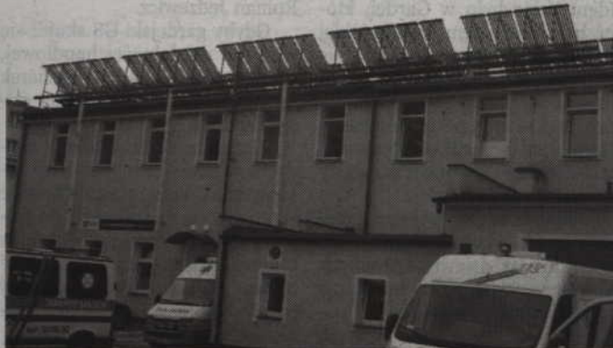
Na dachu kwidzyńskiego szpitala pojawiły się kolektory słoneczne.
