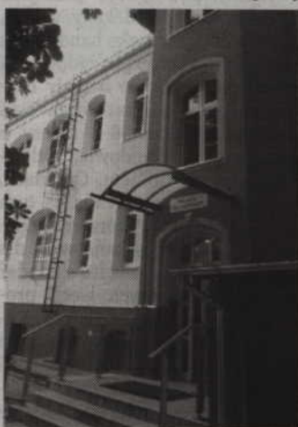
Wyremontowane wejście na oddziały.
