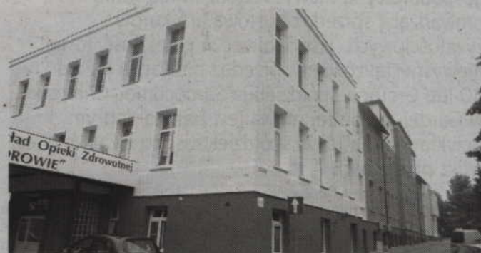
Budynek główny po przeprowadzonych pracach.
