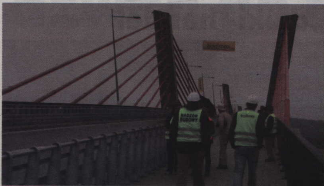
Budowa mostu jest już praktycznie ukończona. Pozostały już jedynie odbiory i czynności administracyjne. Fot. Mirosław Wiśniewski
