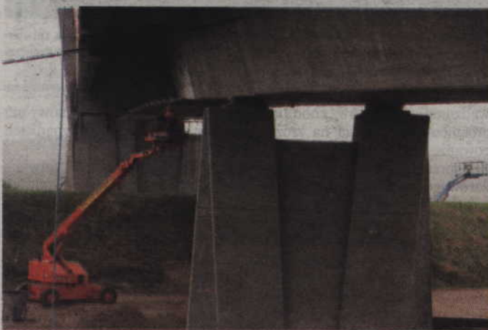
Ostatnie prace przy konstrukcji mostu. Fot. Mirosław Wiśniewski
