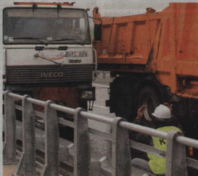
Auta parkowały bardzo blisko siebie, aby dać jak największe obciążenie w danym punkcie.
